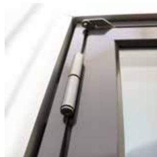
Adjustable hinge, terrace door
