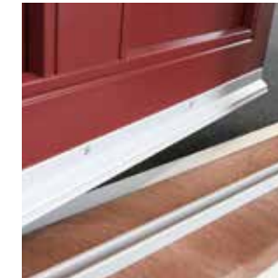
Drip sill Inward opening door
