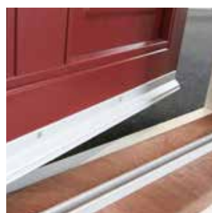
Drip sill Inward opening door
